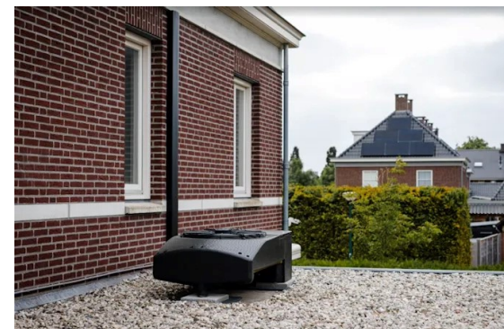
Figuur 10 - Voorbeeld horizontale warmtepomp (voorbeeld WeHeat Blackbird).
