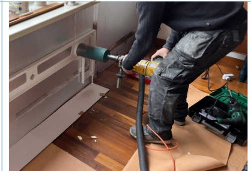
Gaten boren voor een decentrale WTW met ingebouwde lage temperatuur convector
